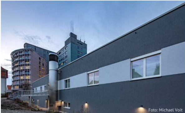
Klinikum Werra-Meißner Krankenhaus Eschwege, Neubau Funktionstrakt - BA 1a
