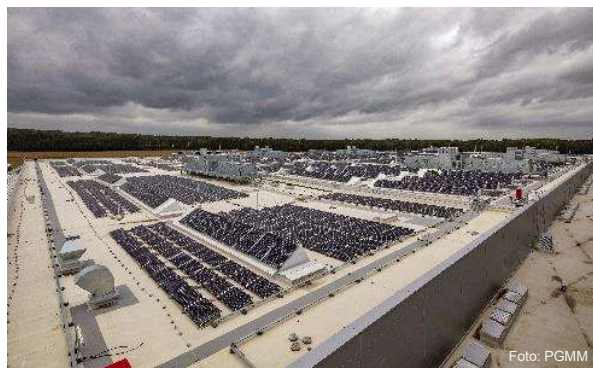
ACCUotive Kamenz Erweiterung Produktionsstandort, Werk II,
