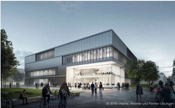
IMBIT Freiburg , Neubau Laborgebäude
