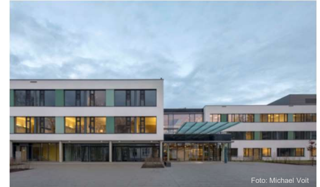
Klinikum Konstanz, Neubau Funktionsgebäude und Vincentius Krankenhaus
