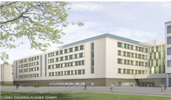
Bundeswehrkrankenhaus Hamburg, Neubau Multifunktionsgebäude / Schifffahrtsmedizinisches Institut der Marine
