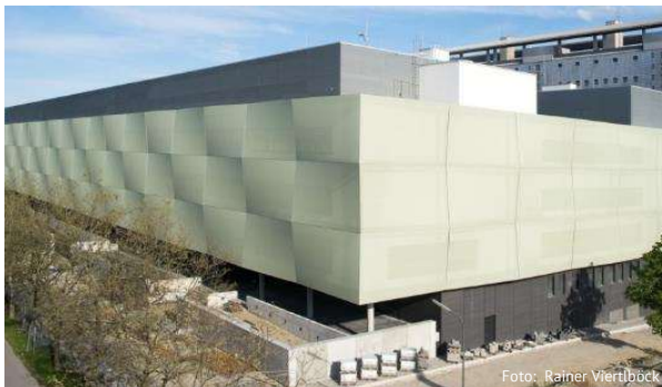
Klinikum München Großhadern Neubau OP-Zentrum
