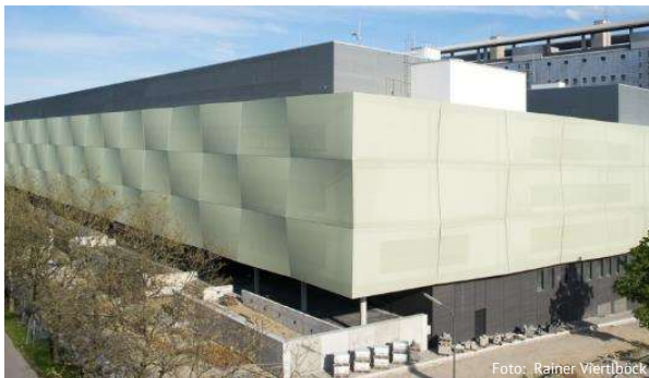
Clinic München Großhadern New operation center
