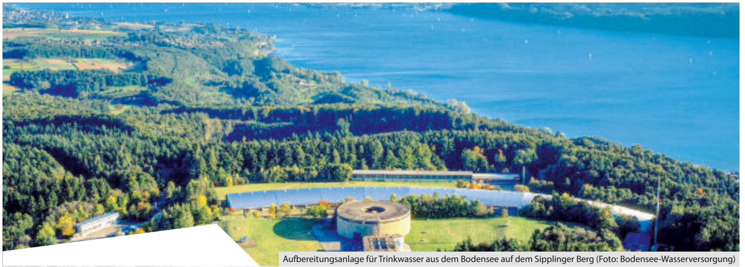
Aufbereitungsanlage für Trinkwasser aus dem Bodensee auf dem Sipplinger Berg (Foto: Bodensee-Wasserversorgung)
