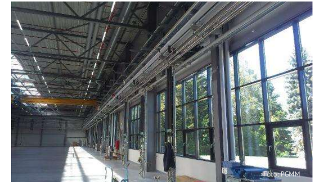
Viega, Werk Elspe, Neubau Bauabschnitte 13, Industriehalle, Sozial- und Bürotrakt
