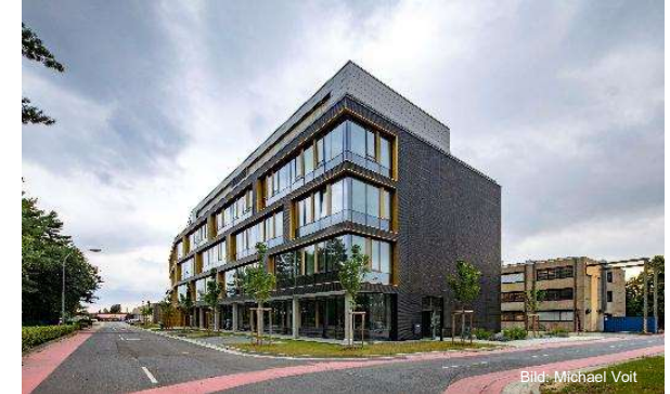
Helmholtz-Zentrum für Infektionsforschung, Braunschweig, Neubau Forschungsgebäude
