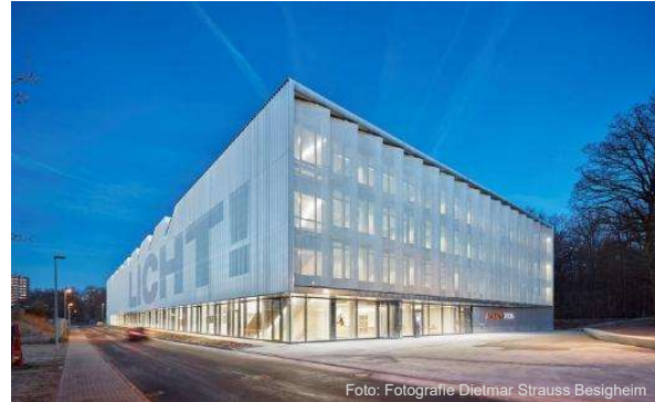
ARENA2036 Stuttgart Neubau Forschungsfabrik
