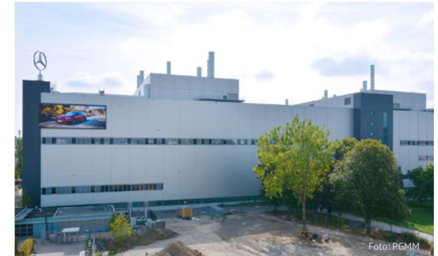
Daimler, Sindelfingen , Generalplanung Erweiterung Geb. 2, Karosseriebau
