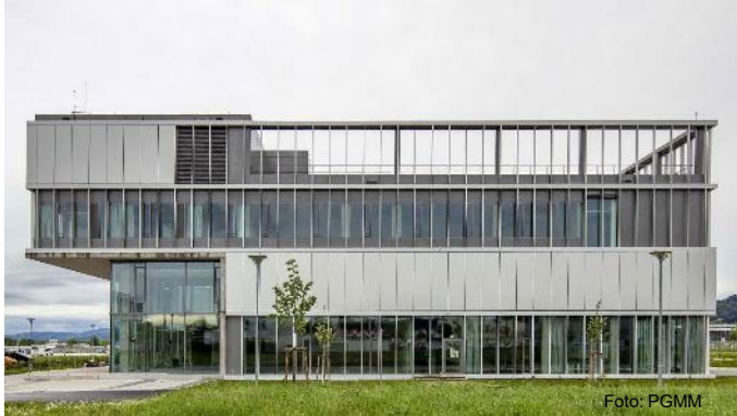
IMBIT Freiburg , Neubau Laborgebäude
