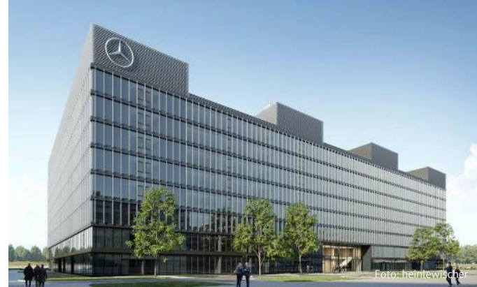
Daimler Sindelfingen Neubau Elektrointegrationszentrum EIZ, mit Prüfstands-, Werkstatt- und Büroflächen (50 %)
