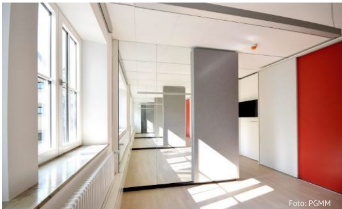
Rathaus Böblingen, Sanierung
