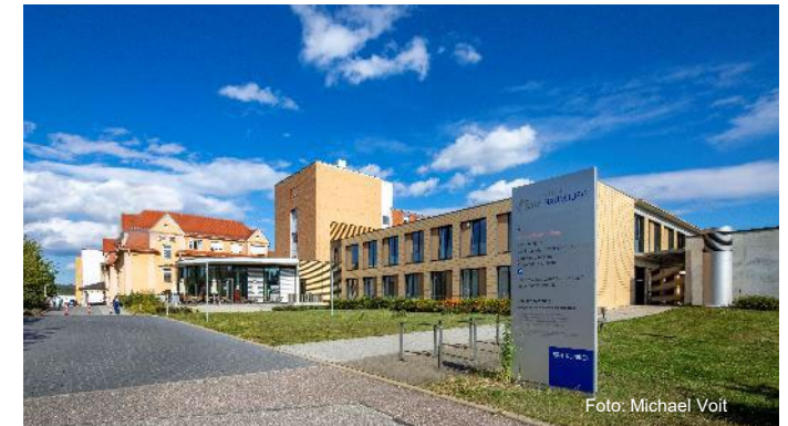
Klinikum Burgenlandkreis , Neubau Kinderzentrum
