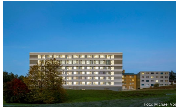
Kliniken HochFranken - Sanierung und Erweiterung Klinik Naila
