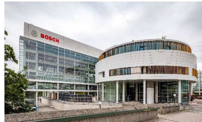
AER Fritz 9 München Revitalisierung und Erweiterung
