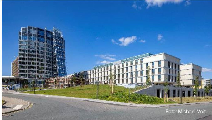
Klinikum Chemnitz gGmbH , Neu- und Umbau zur Zentralisierung von Klinikbereichen
