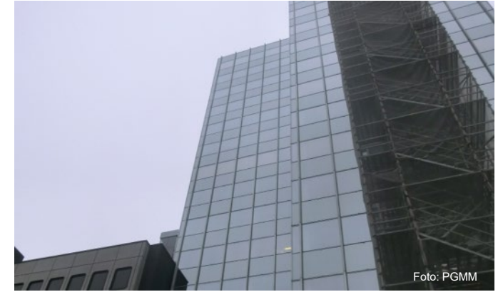
GE Real Estate GmbH, Hochhaus am Turm Frankfurt Reconstruction
