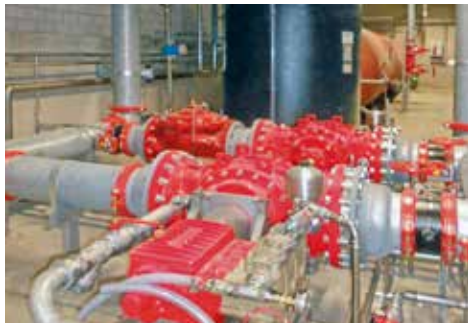
SPZ Audi Böllinger Höfe: Schaumzumischung für 13.800 l/min Löschwasser
