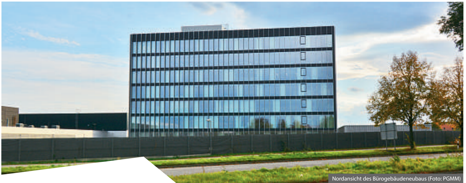
Nordansicht des Bürogebäudeneubaus (Foto: PGMM)
